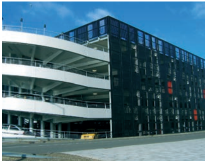
01 Teilansicht Parkhaus mit Wendelrampe
