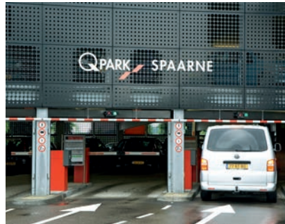
02 Lochblechelemente der Außenfassade über der Parkhauseinfahrt
