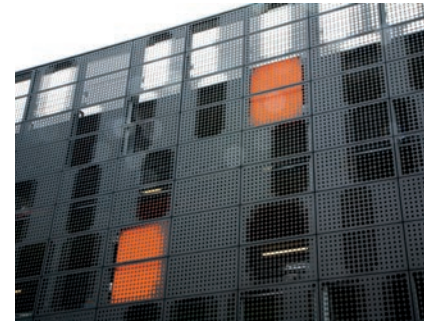
03 Lochblechelemente mit verschiedenen Lochdurchmessern pro Element, teilweise hinterleuchtet in holländischem "oranje".
