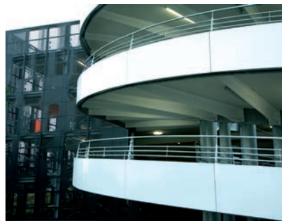
05 Wendelrampe mit Verkleidung
