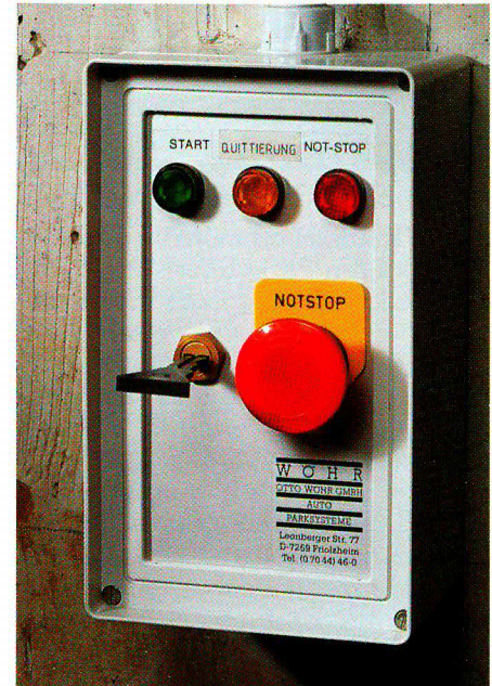
Jeder Benutzer erhält einen eigens für ihn codierten Schlüssel, mit dem er die Parkplatten bedienen kann.
