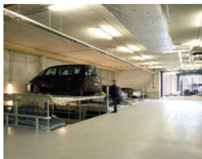
17 ... und können den Schlüssel am Bedienelement nur abziehen, wenn der Parklift wieder abgesenkt und befahrbar für Besucher ist. ... and can only remove the key from the operating device once the Parklift has been lowered to make the upper spaces available for visitors.
