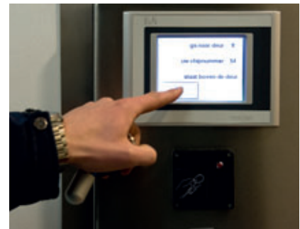
12 Auf dem Display erscheint die Tor-Nr. 6 und die Stellplatz-Nr. 54. Der Fahrer bestätigt seinen Stellplatz am Touch-Screen und die Anlage stellt den angewählten Stellplatz zum Ausparken bereit ... Gate 6 space 54 appears on the screen. The driver confirms his parking space on the touch screen and the system prepares the selected parking space for exit ...
