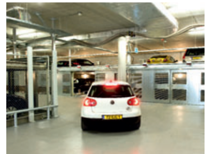
Nur die rechnergestützte Zuweisung macht es für den Fahrer möglich, den nächsten freien Stellplatz hinter den Toren in einer der 3 Parkebenen zu finden. Only the computer-operated allocation makes it possible for the driver to find the next available free space behind the gates on one of the three parking levels.
