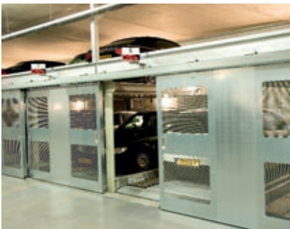
10 Dann schließt sich das Schiebetor automatisch. The sliding door then closes automatically.
