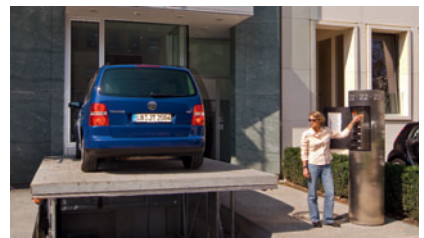
04 | C Das Bedienen der Anlage ist einfach: Die Nutzerin schaltet mit einem Schlüssel die Anlage ein und drückt solange den Auf-Taster, bis ihr Stellplatz angehoben ist, The operation of the system is simple: The user operates the system with a specific key and presses the up button until the parking place has reached the upper position,
