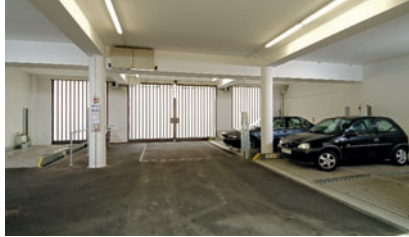
02 | B Links und rechts neben der Fahrgasse sind 10 Stellplätze auf Wöhr Parklift 440 angeordnet. Im Fahrgassenbereich vor dem Zufahrtstor ist der Deckel der Versenkgarage Parklift 461 E erkennbar. Die Deckelfüllung aus Gussasphalt ist der Fahrgasse angepasst. 10 car park places on Wöhr Parklift 440 are installed on the left and right side of the driving lane. In the driving lane itself, right in front of the sliding garage door you can see the lid of the Parklift 461 S. It is filled with asphalt matching the driving lane.
