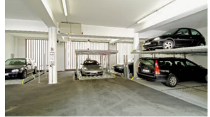
02 | C Der zusätzliche Stellplatz in der Fahrgasse in angehobener Ein- bzw. Ausfahrtstellung. The additional car park place in the driving lane in the raised entry or exiting position.
