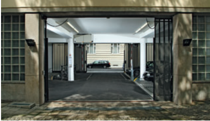
02 | A Die Parkplätze im Innenhof sind von der Strasse aus nur über die sanierte und erweiterte Garage im Gebäude erreichbar. The parking places in the courtyard can be accessed from the street only via the renovated and extended car park of the building
