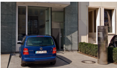
04 | A Stadthaus Berlin Mitte mit Stele und Wöhr Parklift 461 E. Deutlich erkennbar ist die schräge Lage des Steinbelages der Parkliftwanne. Sie dient zur Abgrenzung zum Hauszugang wie zum Nachbarn und zu einer verbesserten Oberflächenentwässerung. Townhouse in Berlin Mitte with steele and Wöhr Parklift 461 S. The inclined stone paving can be clearly seen in the Parklift lid. It also helps to improve the surface drainage.
